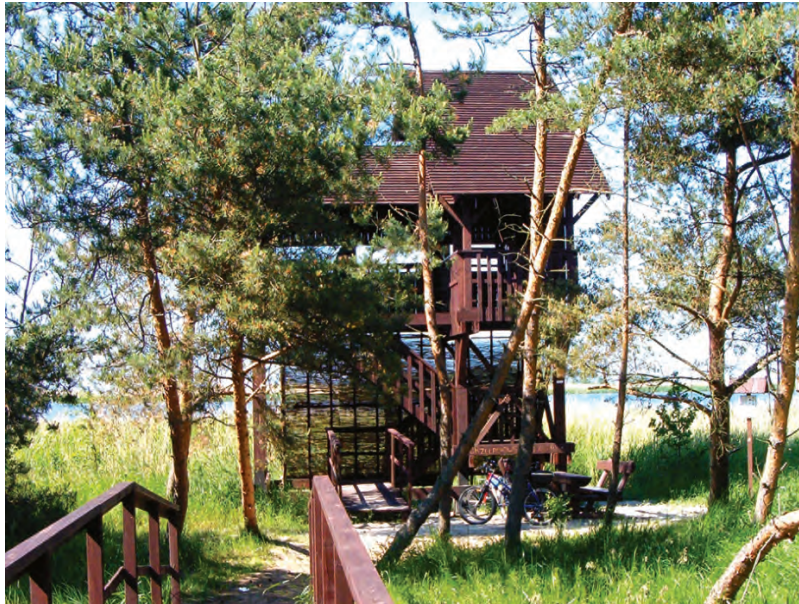
Wieża obserwacyjna na trasie Ścieżki Przyrodniczo-Dydaktycznej
