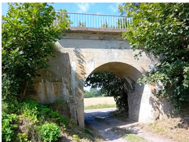
Zachowany w dobrym stanie przepust kolejowy w Przegalinie – 2024 r.
