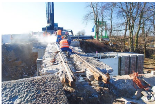
Likwidacja mostu i torów kolei wąskotorowej nad Śluzą Północną w Przegalinie – 2012 r.
