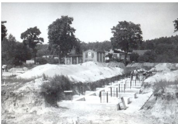
Budowa fundamentów nowego kościoła w Świbnie. Fot. Ks. R. Wołos
