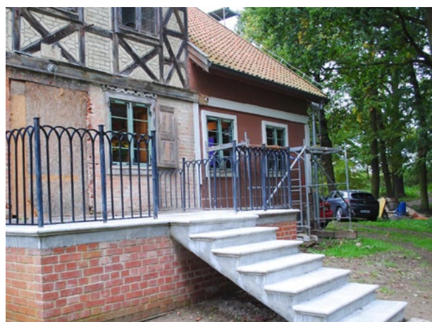
Odrestaurowany taras budynku mieszkalnego Zagrody /fot. Waldemar Nocny
