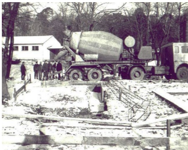
Pierwsze prace przy budowie nowego kościoła w Sobieszewie – 1988 r.
