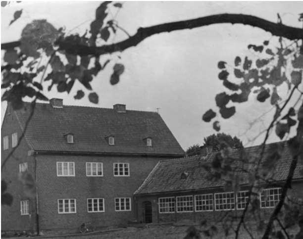
Budynek szkoły w Świbnie przed rozbudową. Fot. T. Wiśniewski
