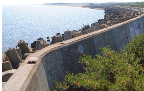
Opaska brzegowa z narzutem kamiennym i gwiazdoblokiem – 2014 r.
